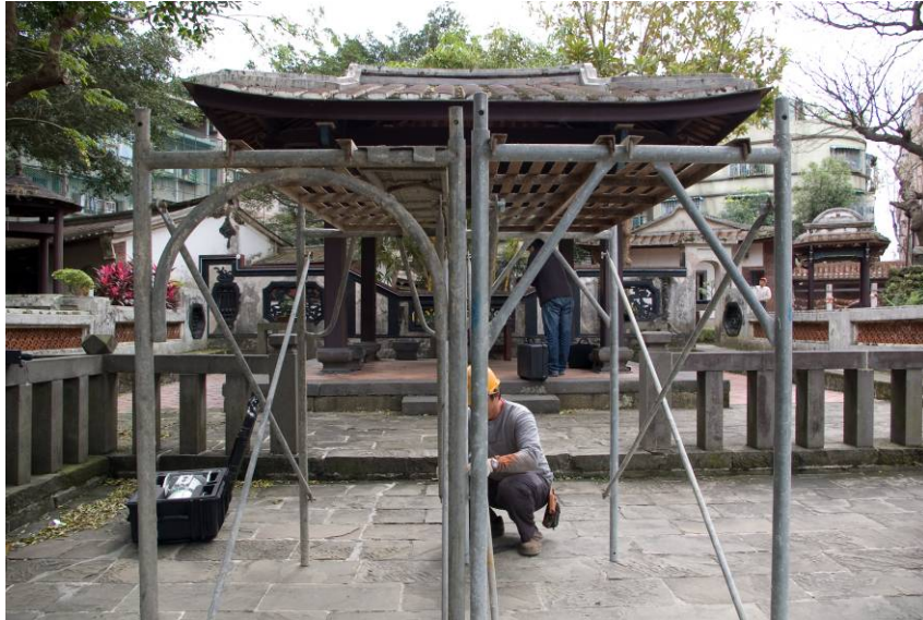
圖 1：架設鷹架以配合古蹟主體高度
