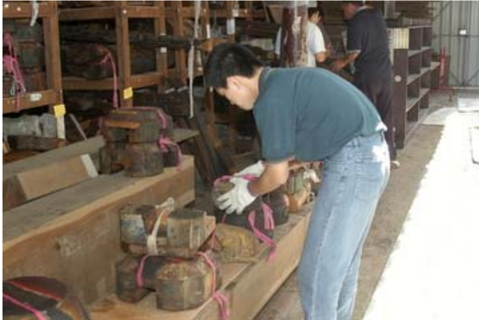
圖 3：助理執行構件清潔作業
