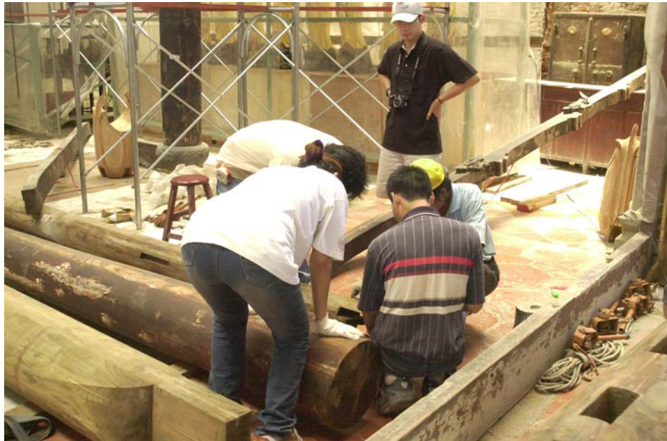
圖 2：與現場施工人員確認構件
