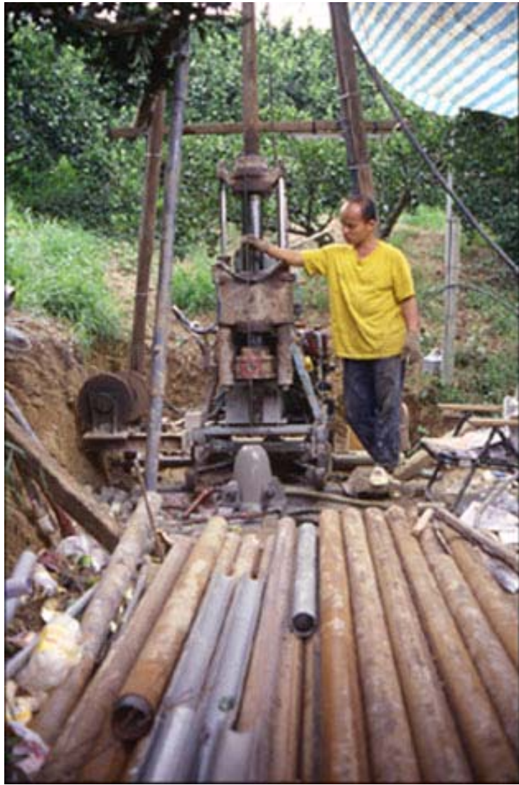
圖二十五、岩心工程施工情形
