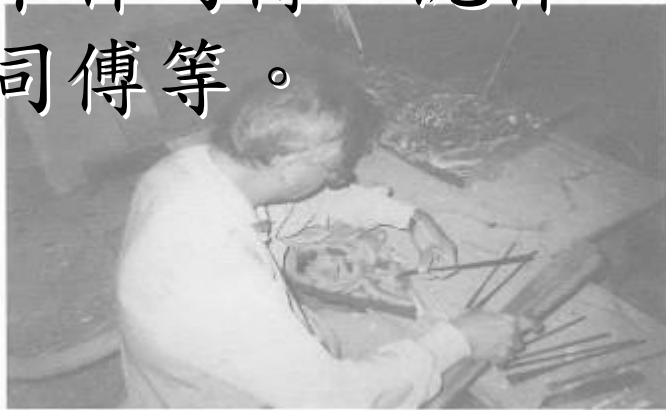
【正殿步口雀替損壞修補】
