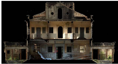
圖5-2-6、建築本體破壞紀錄與量測 (陳清吉洋樓，金門金沙，1931)
