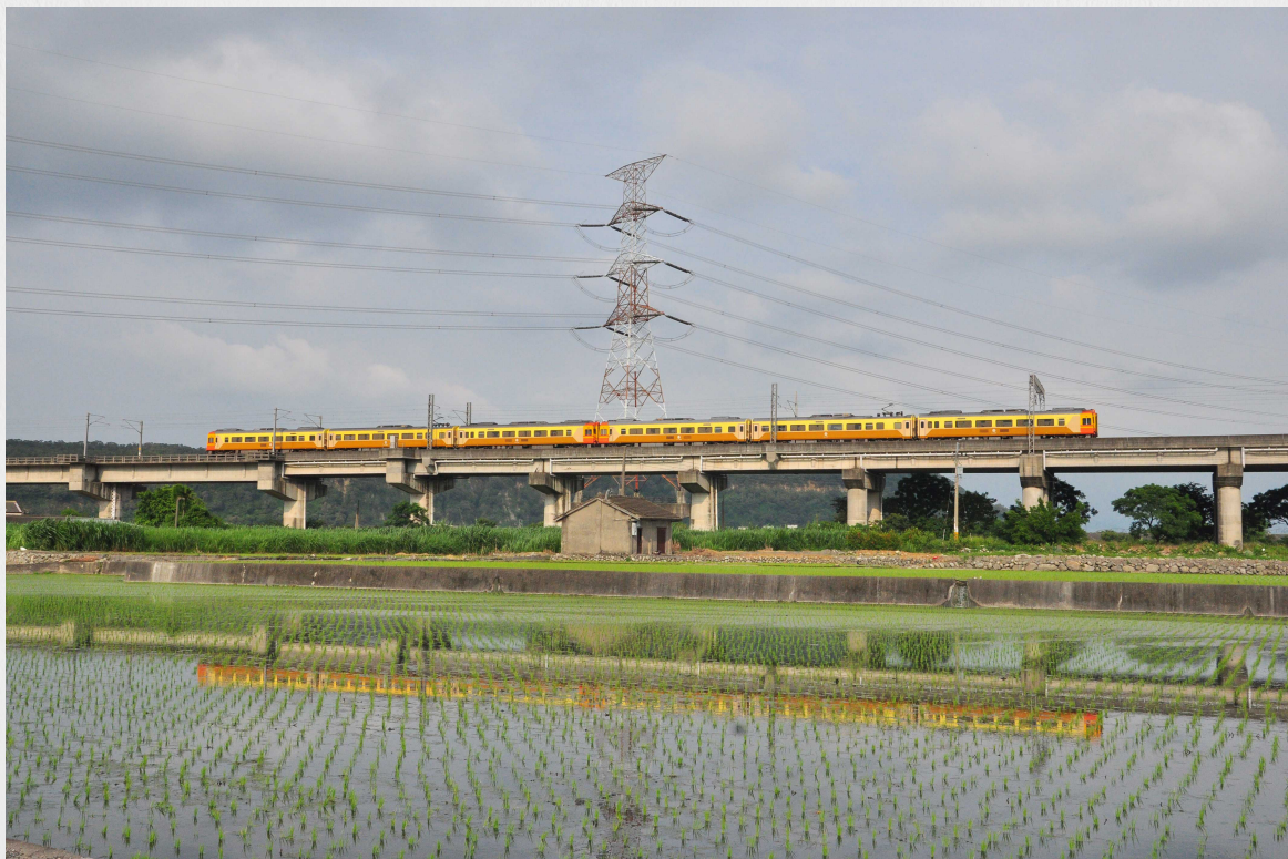
圖 08：〈EMU300型電聯車行走於山線的高架橋〉，蘇昭旭攝，年份：2011。圖片提供者：蘇昭旭。網站名稱：蘇昭旭老師的全球鐵道視野部落格。
