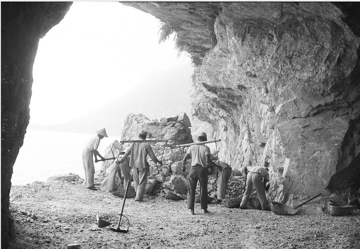
圖 03：〈人工搶修蘇花公路坍方災害道工清除作業〉。圖片提供者：交通部公路總局第四區養護工程處。網站名稱：數位島嶼。
