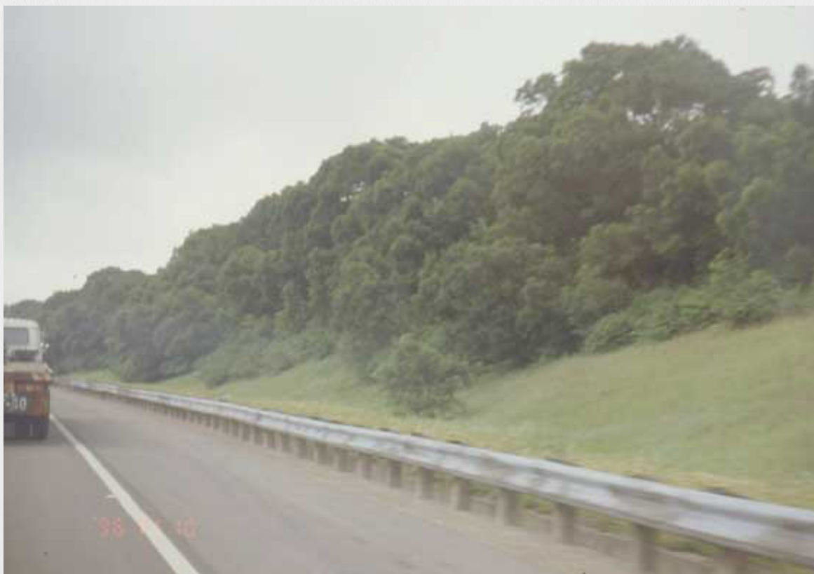
圖 08：生態綠化植被演替狀況，由左至右分別為：植草→生態綠化初期→生態綠化穩定期。 〈生態綠化植被演替狀況 (生態綠化穩定期)〉，王惠敏攝。圖片提供者：交通部臺灣區國 道高速公路局。網站名稱：數位島嶼。
