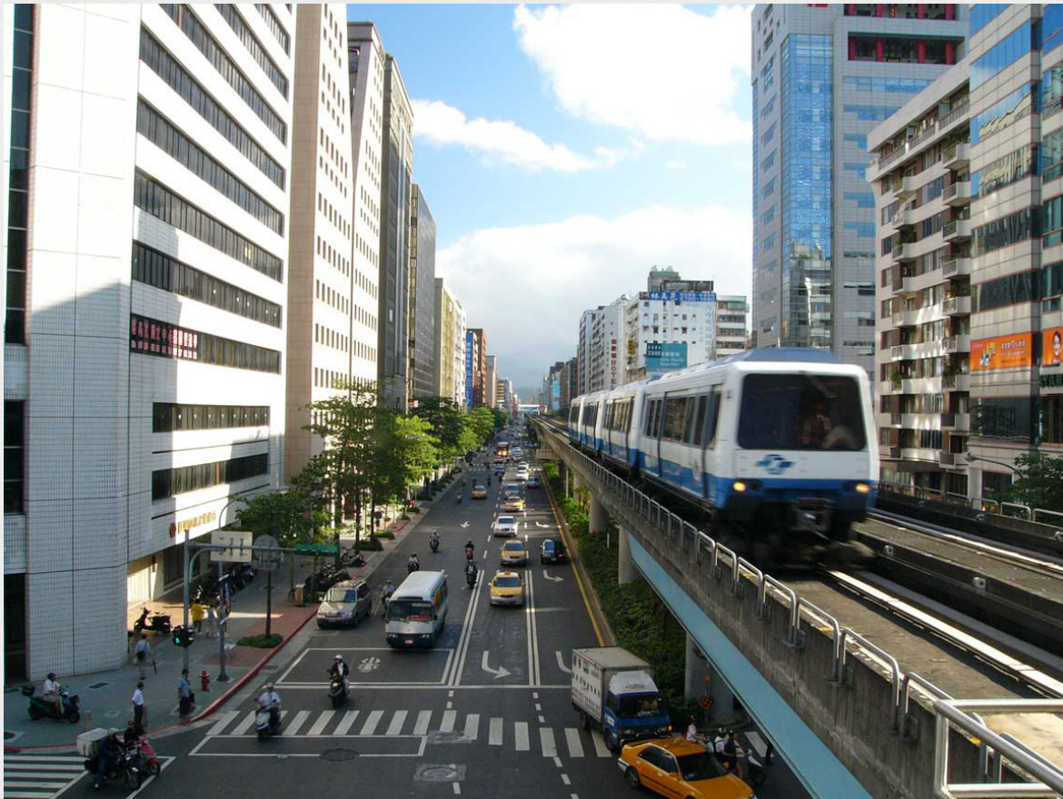
圖 03：中運量系統，採高架方式的臺北捷運文湖線。〈臺北捷運〉，年份：2006。圖片提供者：gtvsng。網站名稱：數位島嶼。
